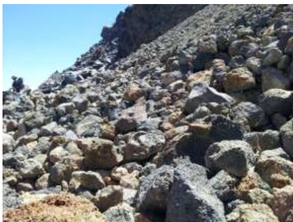
a) Caídas y desprendimientos en sector alto de las termas. Camino a Aguas calientes.
