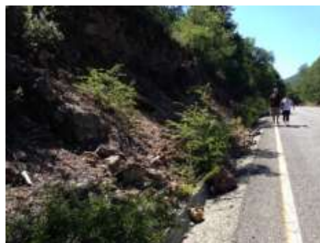
b) Caídas de rocas en camino principal Ruta 55
