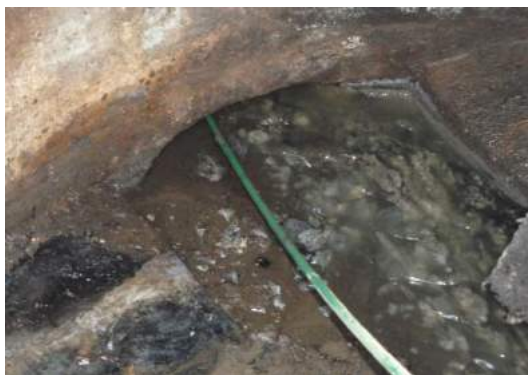
Figura 25. Embancamiento en colector y cámara de aguas servidas. Fuente: Plan de mantenimiento preventivo de redes Essbio S.A.
