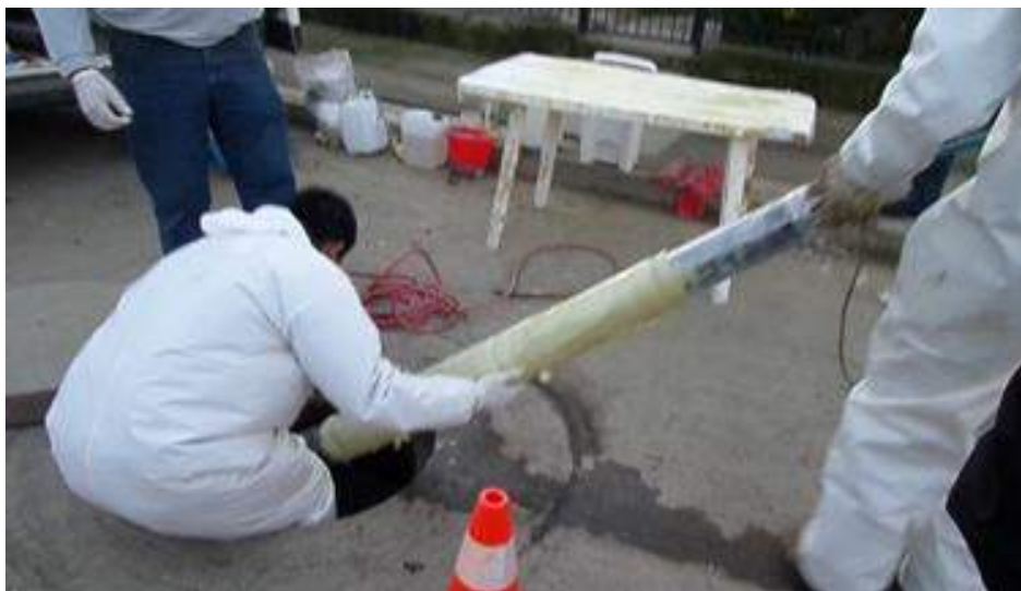
Figura 50. Reparación de colector, mediante método CIPP. Ingreso de parche a colector. Fuente: Plan de mantenimiento preventivo de redes, Essbio S.A.
