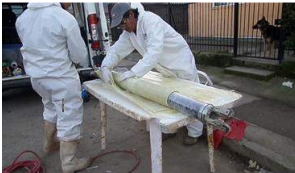
Figura 49. Reparación de colector fisurado, mediante método CIPP. Preparación de parche. Fuente: Plan de mantenimiento preventivo de redes, Essbio S.A.
