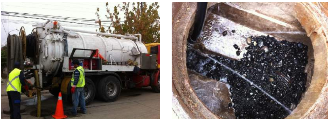
Figura 66. Limpieza de colector obstruido, mediante camion combinado. Fuente: Plan de mantenimiento preventivo de redes, Essbio S.A.
