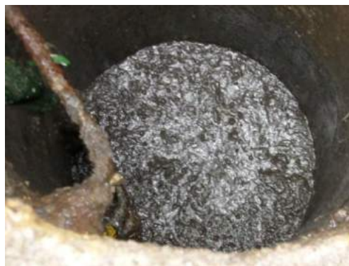
Figura 25. Embancamiento en colector y cámara de aguas servidas. Fuente: Plan de mantenimiento preventivo de redes Essbio S.A.
