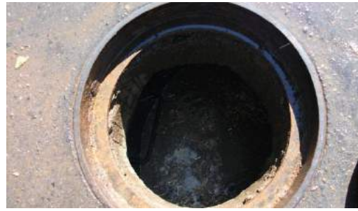
Figura 22. Cámaras de aguas servidas con nivel. Fuente: Plan de mantenimiento preventivo de redes Essbio S.A..
