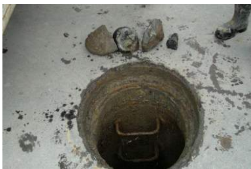
Figura 27. Retiro de escombros desde cámara de aguas servidas. Fuente: Plan de mantenimiento preventivo de redes Essbio S.A.
