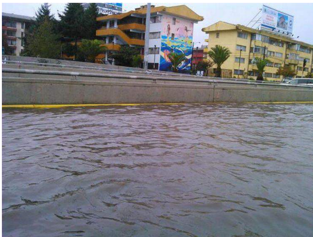
Figura 28. Inundación por lluvia intersección de calles carrera con paivai Fuente: www.soychile.cl
