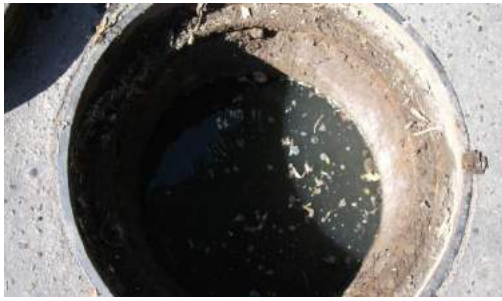
Figura 22. Cámaras de aguas servidas con nivel. Fuente: Plan de mantenimiento preventivo de redes Essbio S.A..
