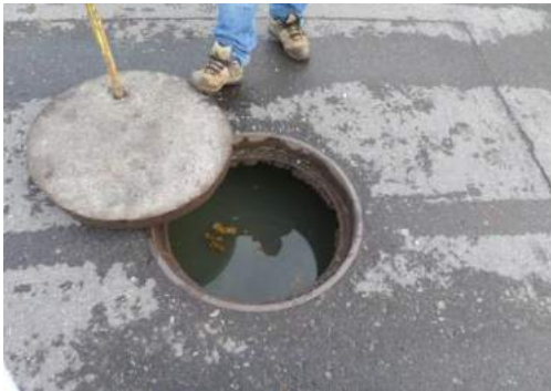
Figura 23. Cámaras de aguas servidas con nivel. Fuente: Plan de mantenimiento preventivo de redes Essbio S.A..
