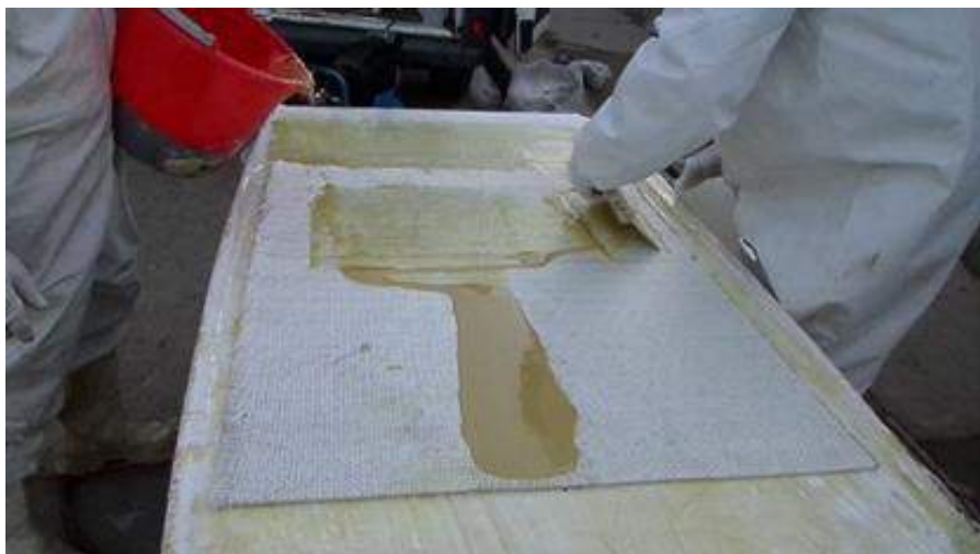
Figura 48. Reparación de colector fisurado, mediante método CIPP. Aplicación de resina epóxica Fuente: Plan de mantenimiento preventivo de redes, Essbio S.A.
