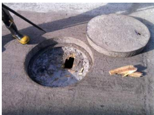
Figura 26. Retiro de escombros desde cámara de aguas servidas. Fuente: Plan de mantenimiento preventivo de redes Essbio S.A.
