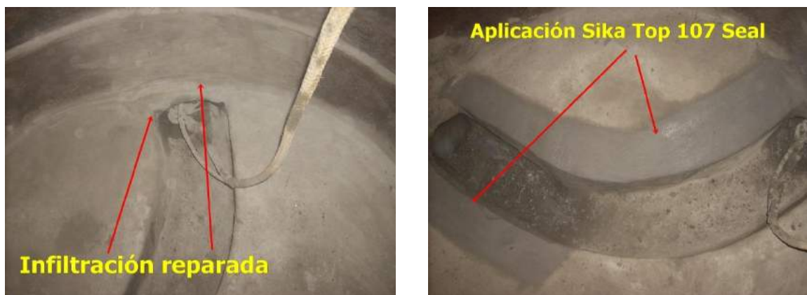
Figura 62. Reparación de infiltración en cámara de aguas servidas. Fuente: Unidad de infiltración, Essbio S.A.
