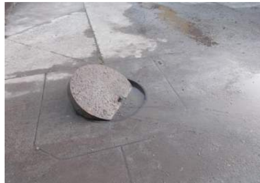
Figura 24. Afloramiento de aguas servidas en via pública. Fuente: Plan de mantenimiento preventivo de redes Essbio S.A.
