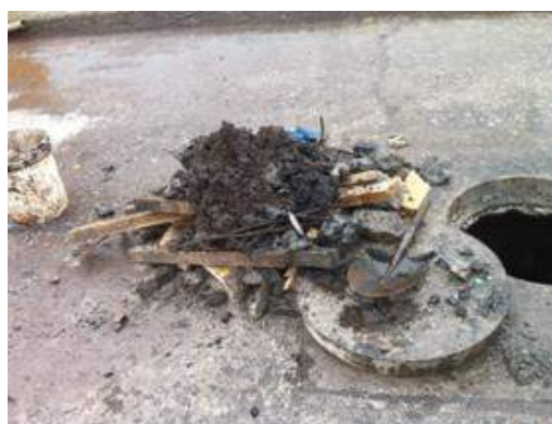
Figura 26. Retiro de escombros desde cámara de aguas servidas. Fuente: Plan de mantenimiento preventivo de redes Essbio S.A.
