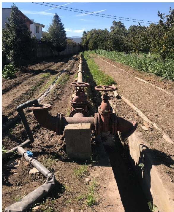
Figura 19. Canales de riego, La Cruz.
