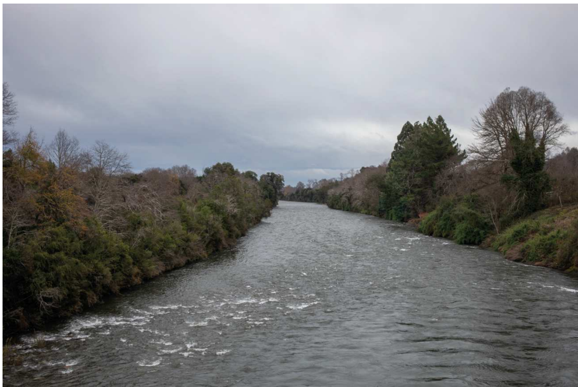
FIG. 77 Río Cautín junto a Villa Cautín. Junio de 2024. Fuente: Elaboración propia.
