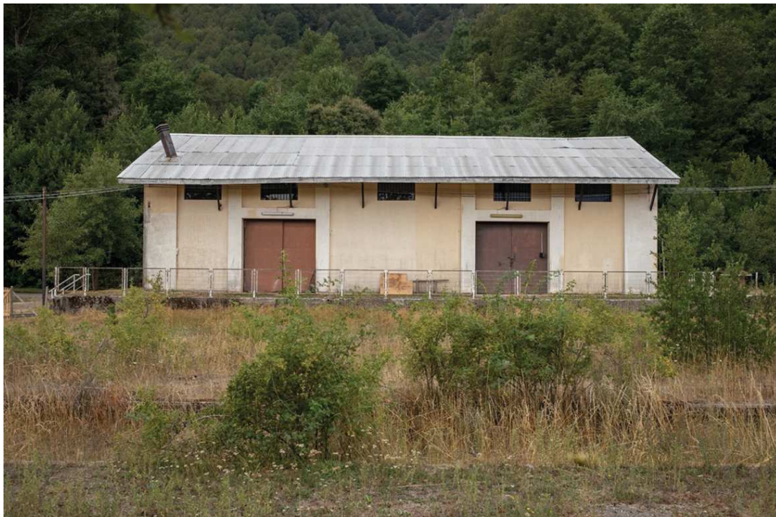
FIG. 84 Sala de Máquinas, estación ferroviaria de Manzanar. Febrero de 2024. Fuente: Elaboración propia.
