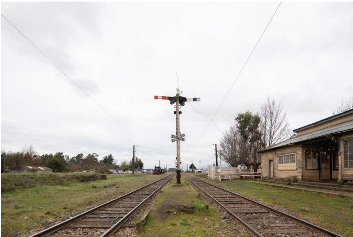
FIG. 62 Trocha de la Red Central del Ferrocarril en Púa, vista hacia Lautaro-Temuco (sur). Fuente: Elaboración propia.
