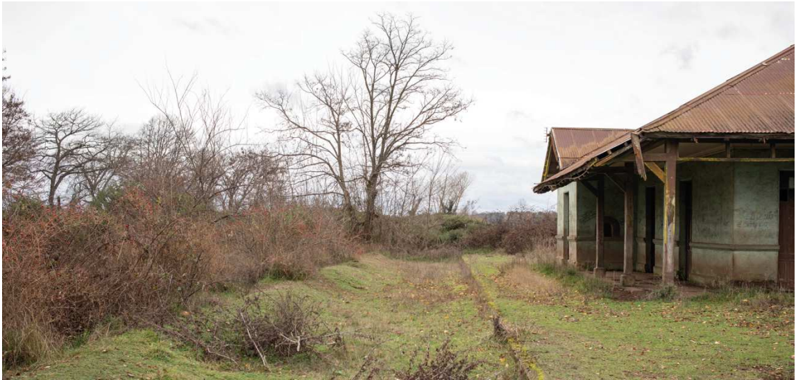
FIG. 48 Fotografía del andén de la estación de Cullinco. Julio de 2024, Fuente: Elaboración propia.
