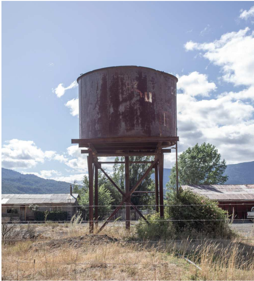
FIG. 91 Toma de agua en la ex_estación de Lonquimay, sitio ocupado actualmente por particulares. Fuente: Elaboración propia.
