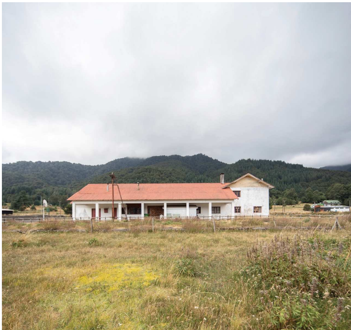
FIG. 85 Estación ferroviaria de Malalcahuello. Febrero de 2024. Fuente: Elaboración propia.
