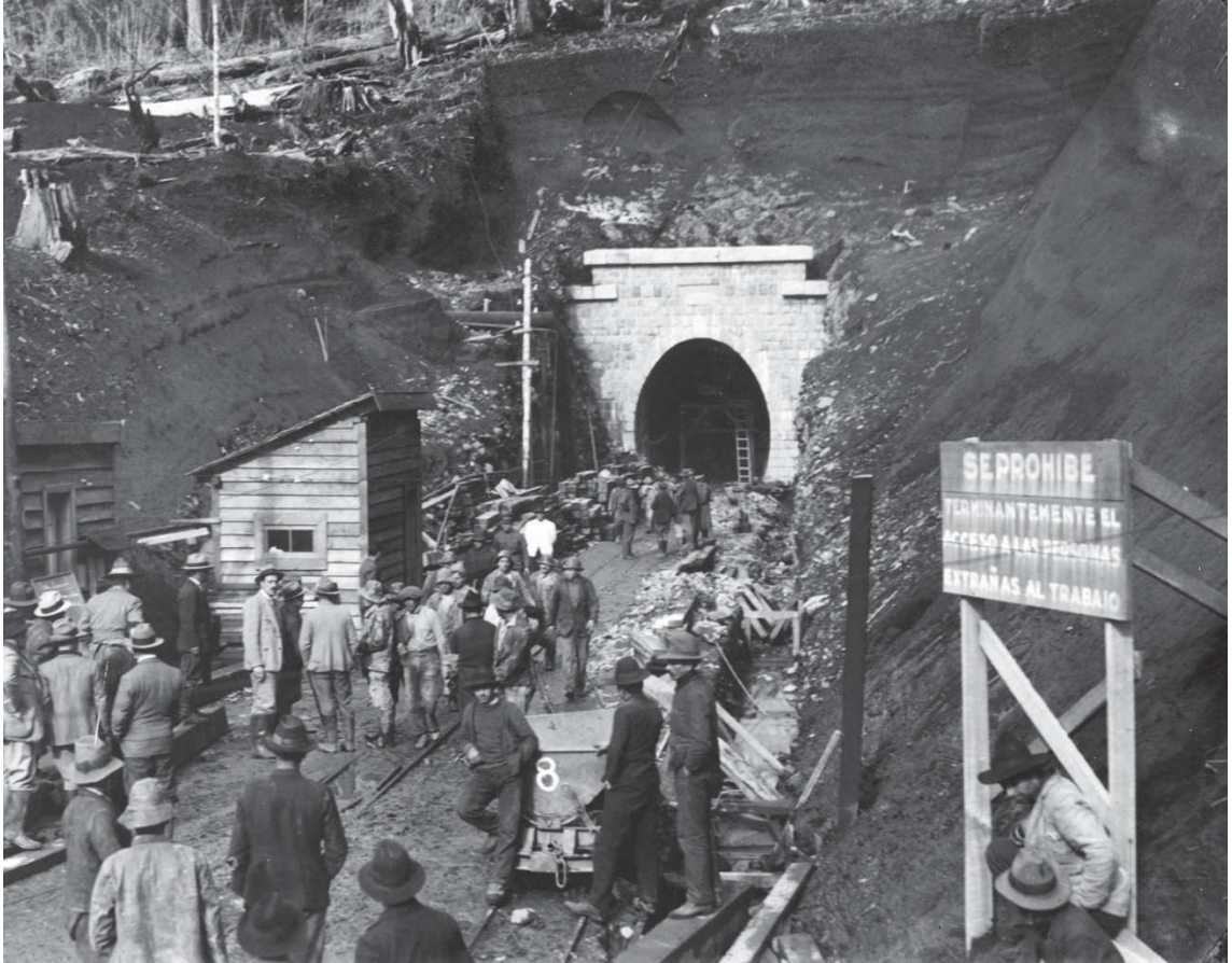
FIG. 7 Construcción Túnel Las Raíces. Fuente, Museo de Historia Nacional.
