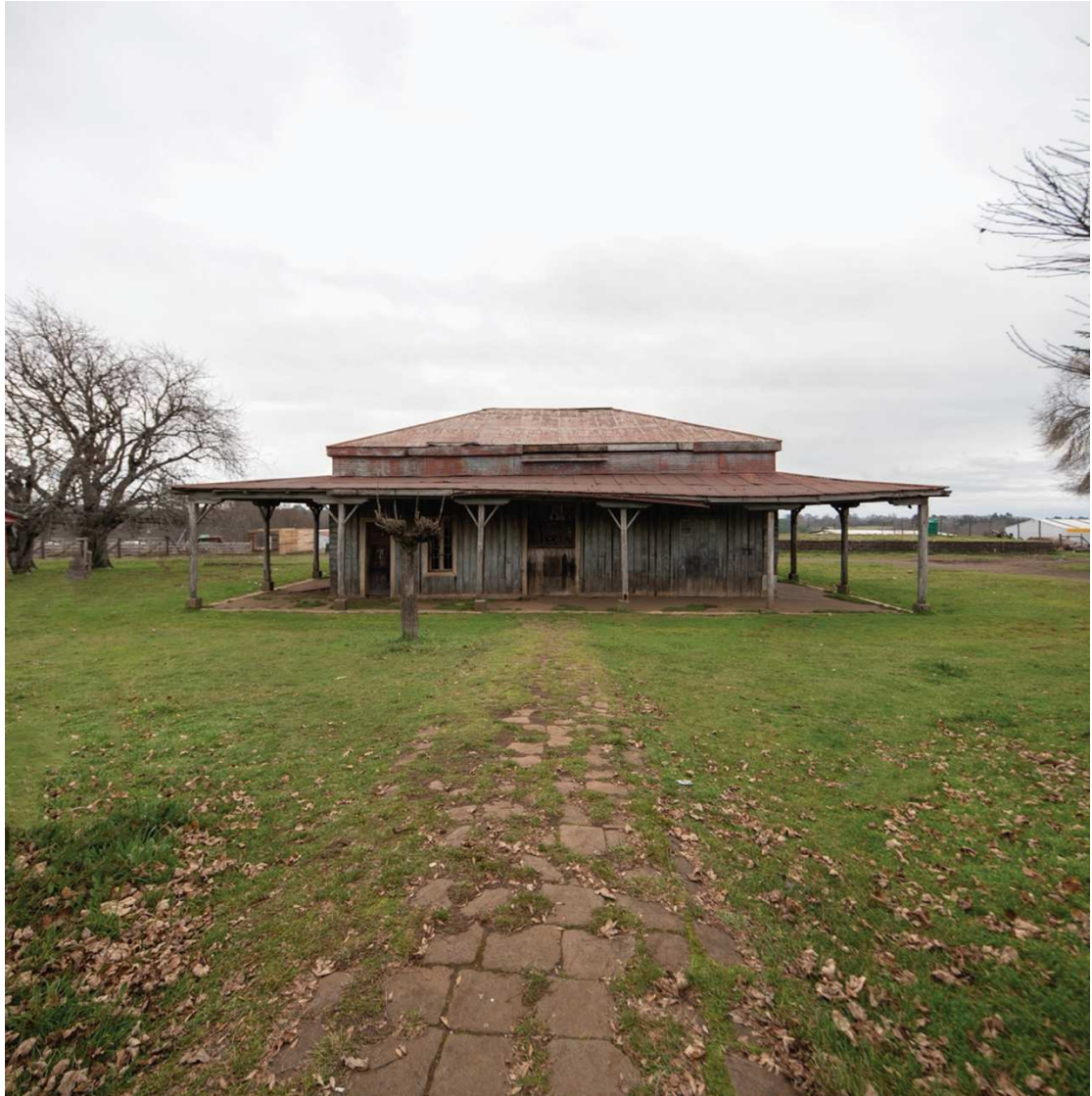
FIG. 73 Fachada Norte de la Estación de trenes de Selva Oscura. Junio de 2024. Fuente: Elaboración propia.
